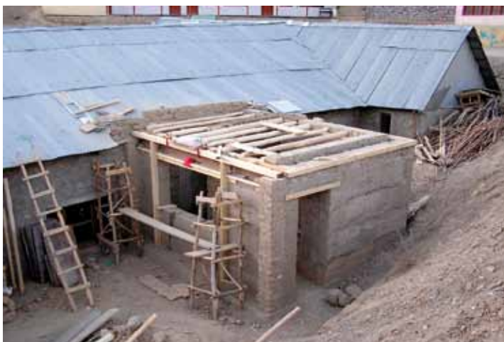
ZKUŠEBNÍ BUDOVA; POLOŽENÍ DŘEVĚNÉHO ZTUŽUJÍCÍHO VĚNCE A STROPNÍCH TRÁMŮ.
