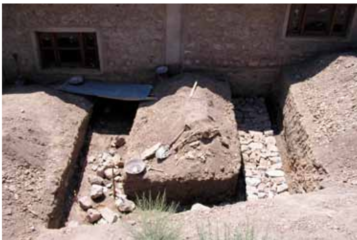
ZKUŠEBNÍ BUDOVA; ZÁKLADY JSOU SMÍŠENÉ, ALE MASIVNÍ. OBLAST JE SEIZMICKY AKTIVNÍ.
