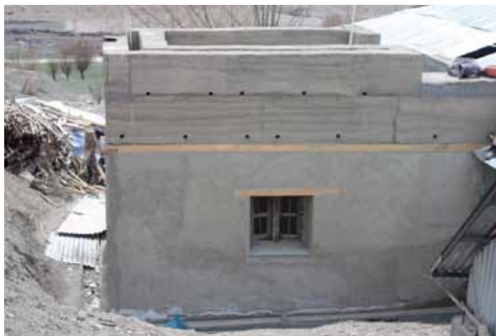
ZKUŠEBNÍ BUDOVA; ZAČÁTEK BUDOVÁNÍ STŘEŠNÍ NÁSTAVBY, V NÍŽ BUDE UMÍSTĚN ZÁSOBNÍK TEPLÉ VODY SE SOLÁRNÍM OHŘEVEM.
