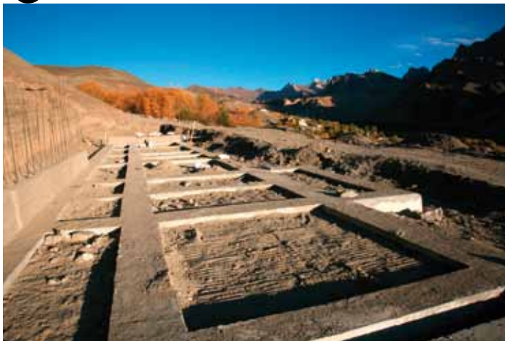
ZÁKLADY INTERNÁTU; STAV NA PODZIM 2011.
