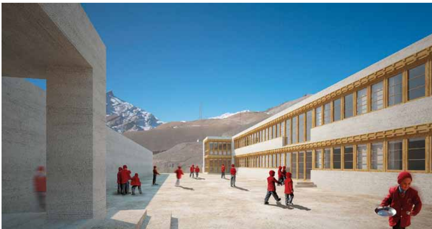
1 Dvůr mezi samostatně stojícími budovami po dokončení kampusu; stěny za předsaženými prosklenými fasádami akumulují přes den tepelnou energii a postupně ji uvolňují během večerních a nočních hodin; vizualizace.
